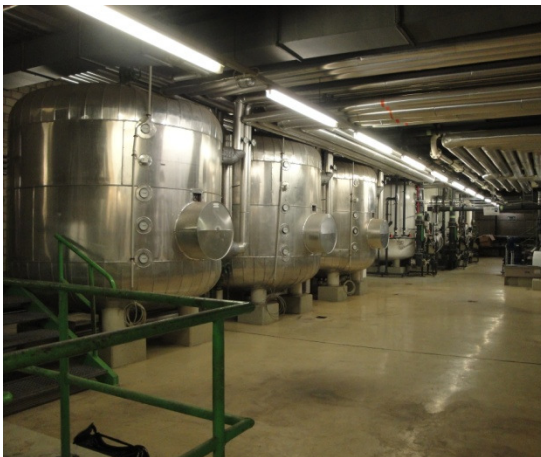
Warmwasserspeicher
