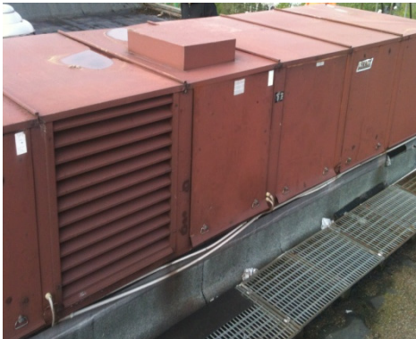
RLT Dachgerät Schwimmhalle
