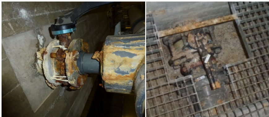
Rasterklappe Rohwasser Nichtschwimmerbecken
