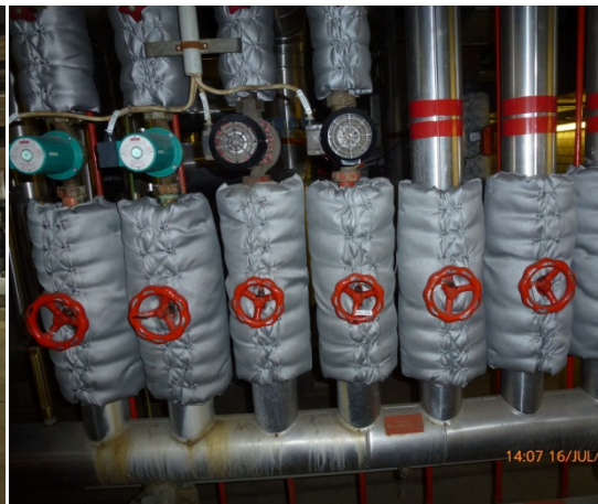
Zirkulationsverteiler
