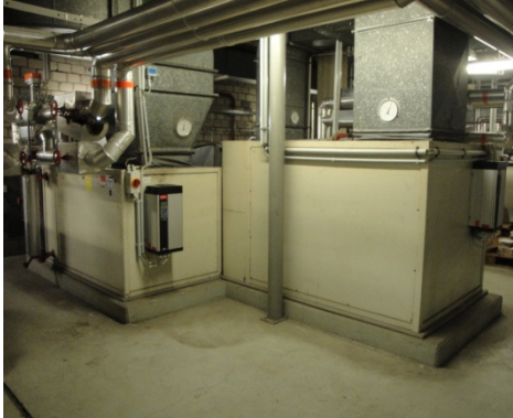
RLT Zuluftgeräte Technikkeller
