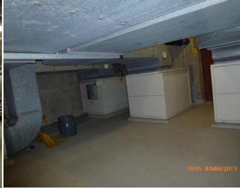
RLT Abluftgeräte Technikkeller
