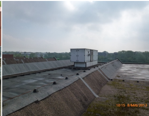
RLT Dachgerät Schwimmhalle
