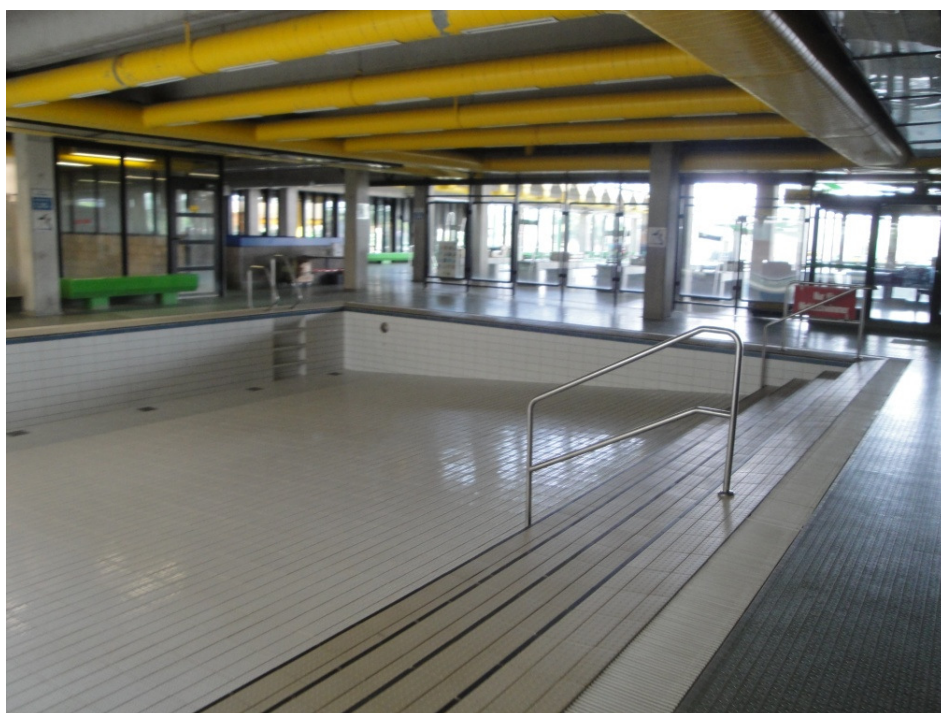
Abb. 4. 3.3: Lehrschwimmbecken mit Wassergewöhnungstreppe
