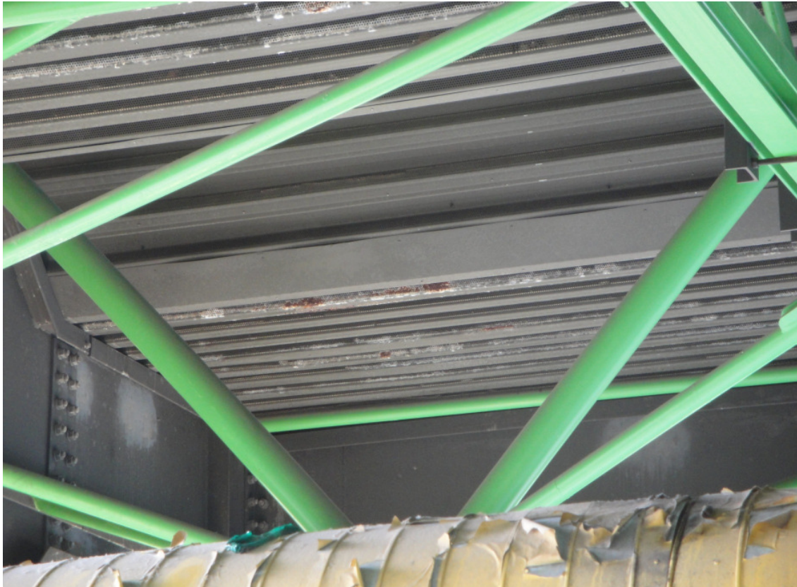
Abb. 5.3.1 Korrosion am Dachtrapezblech
