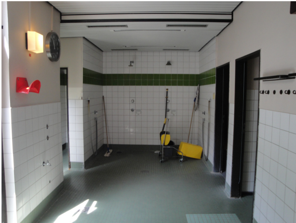
Abb. 4.4.1 Abkühlbereich und Zugang zum Ruheraum
