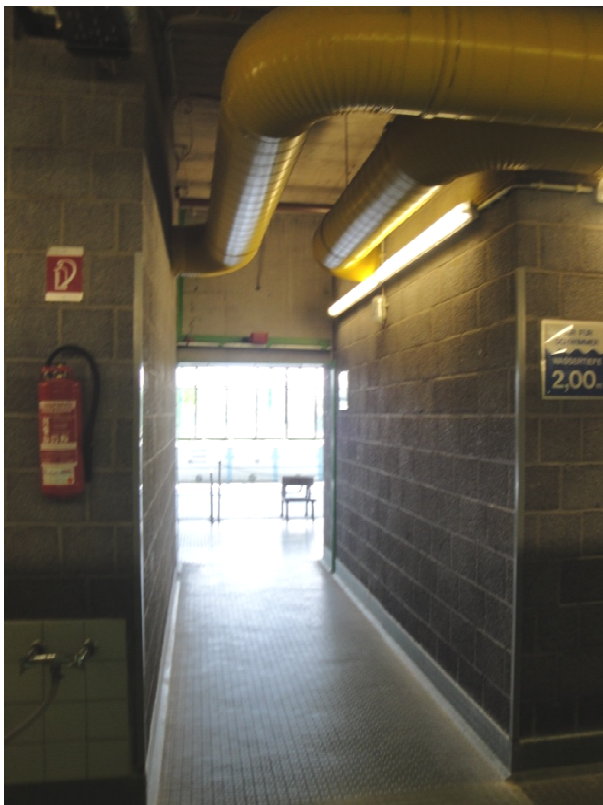
Abb. 4.7.9 Fehlende klimatische Abtrennung (Übergang Schwimmhalle / Umkleiden offen)
