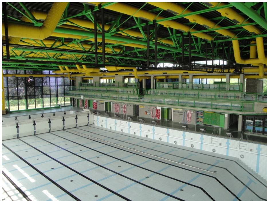
Abb. 4. 3.2: Tribüne am 50-Meter Sportbecken
