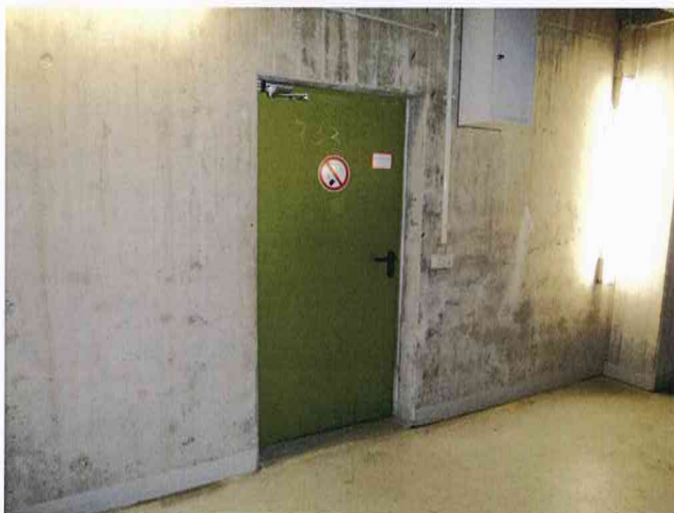
Bild 11: FH-Tür mit Asebstpappe im Schlossbereich, Beispiel
