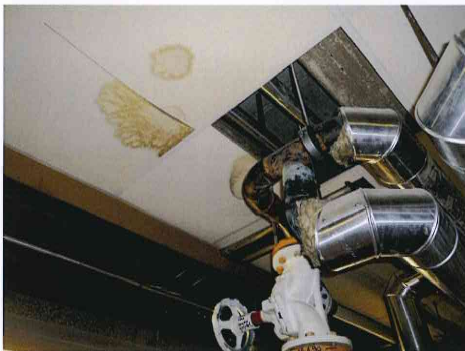
Bild 15: Unterdecke mit KMF-Auflage, Raum Filteranlage, E 0
