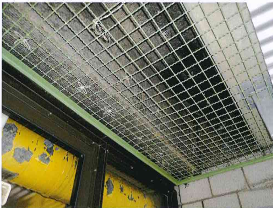
Bild 18: KMF-Isolierung an Dachüberstand Außenbereich, Ebene 2
