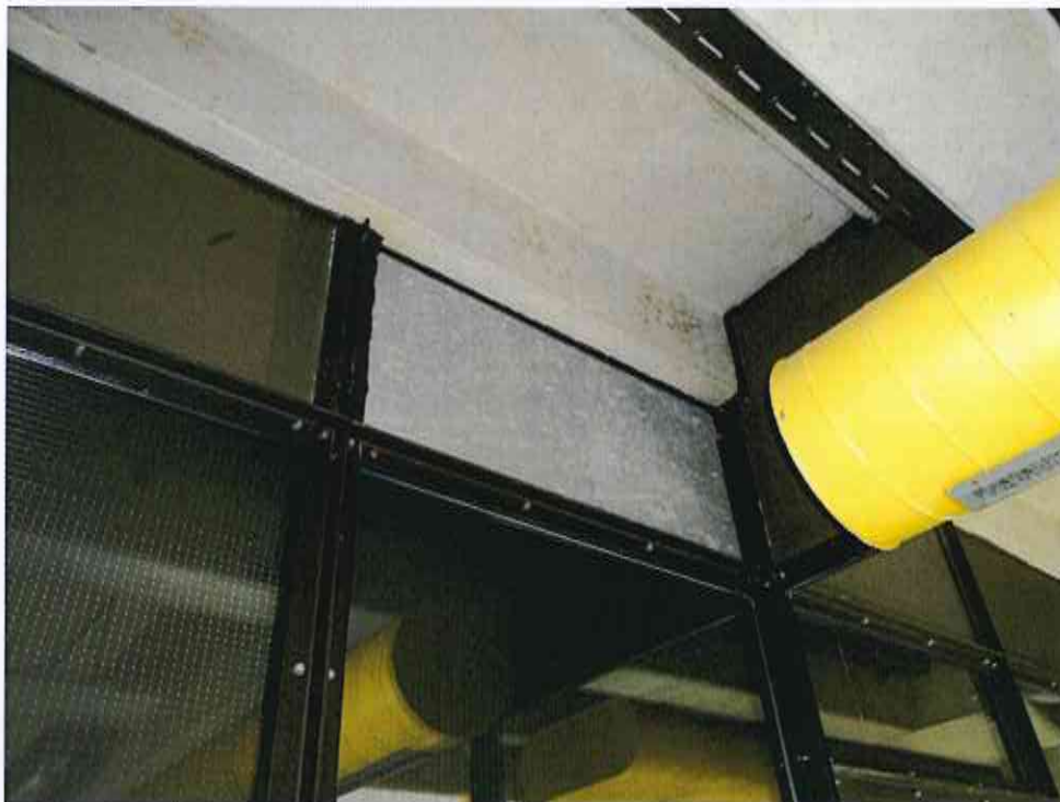
Bild 10: Asbestzementplatte Ruheraum
