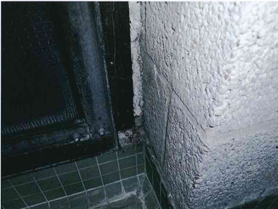
Bild 9: Detail Asbestschnur aus Bild 8
