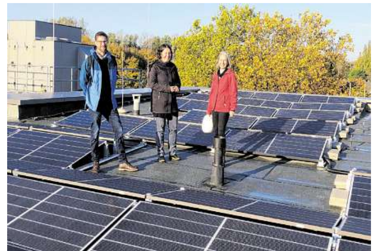
Installiert ist die Solaranlage auf dem Schuldach schon mal. Jetzt muss sie nur noch funktionieren. FOTO: IMMOBILIEN BREMEN
